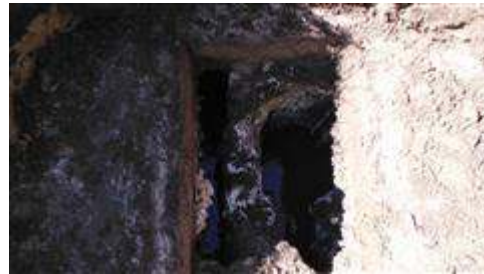
Outlet baffle
