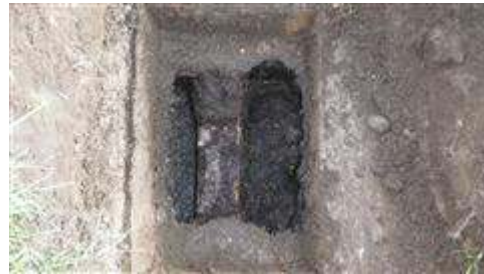
Inlet baffle
